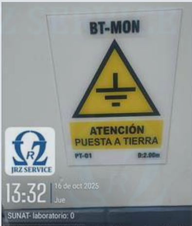
FIGURA 14 – Finalización del mantenimiento a la puesta a tierra.
