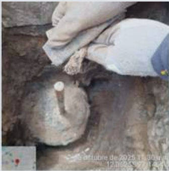
FIGURA 6 – Limpieza y retiro de sulfatación con cepillo de metal y lija para metal.
