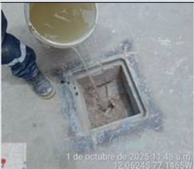
FIGURA 10 – Aplicación de agua sobre la Bentonita y tierra de chacra.
