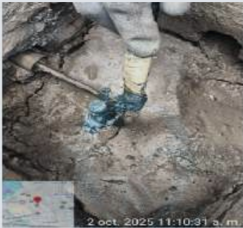
FIGURA 12 – Implementación del nuevo conector AB, engrasado con grasa conductiva.
