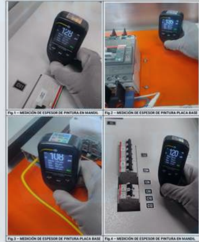
PRUEBA DE ESPESOR DE PINTURA
