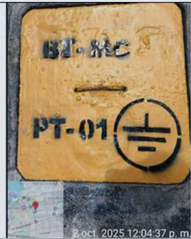
FIGURA 13 – Pintado de tapa y caja de la puesta a tierra.
