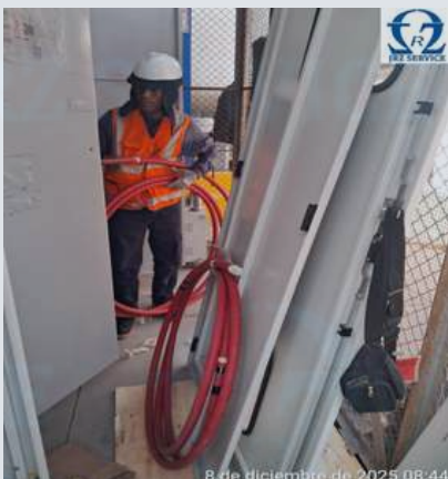
Tendido de cables de MT en celda de transformación.
