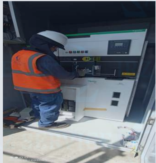
bloqueo de la celda en la subestación y Mantenimiento interno.
