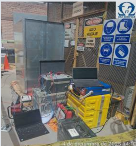
Pruebas de relé e interruptor antes del montaje.
