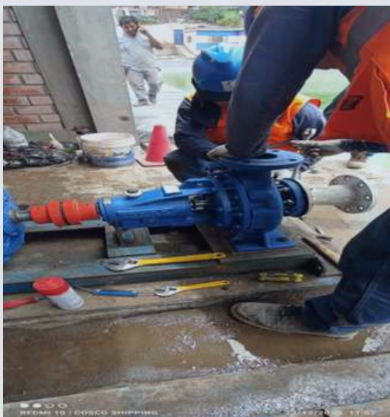
Desmontaje del sistema de bombeo Y Montaje de tubería HDPE para el sistema de bombeo 2 del tablero TB-3 corregido
