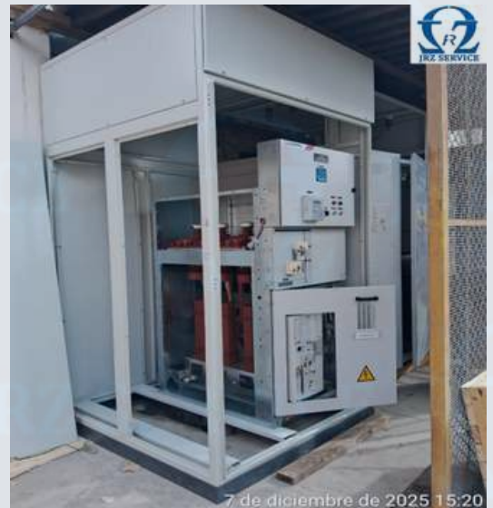
Montaje de celda de protección y remonte.
